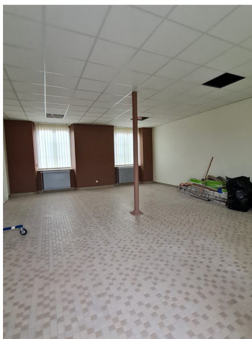
La salle de conseil et des cérémonies de la mairie, en cours de rénovation.
