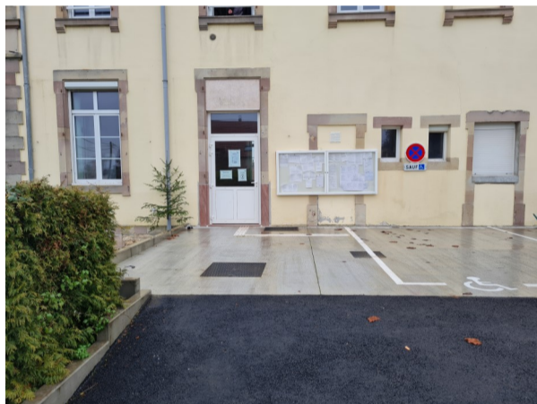
La nouvelle entrée de la mairie, accessible aux personnes à mobilité réduite.
